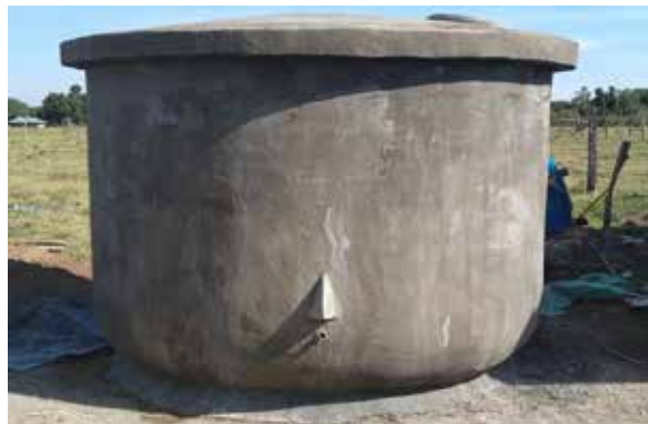
Nieuwe cistern 8000 L.
