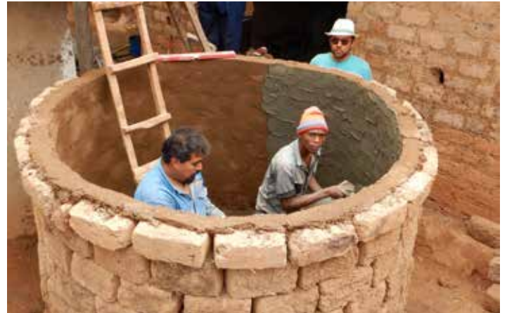
De 1e cement laag aan de binnenzijde van de mal
