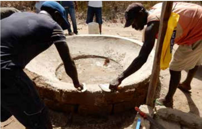
Het boetseren van de holle ronding van de mal
