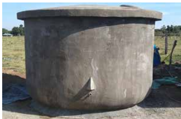
Nieuwe cistern 8000 L.
