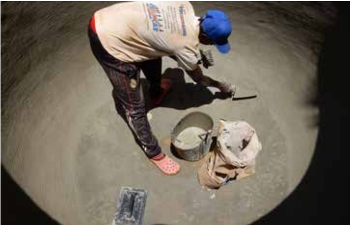
Afwerking van de binnenkant van de Calabash Cisterne
