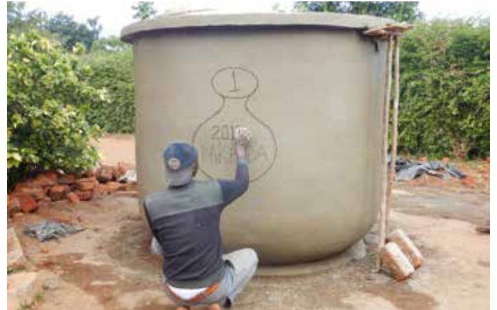
Afwerking van de buitenzijde
