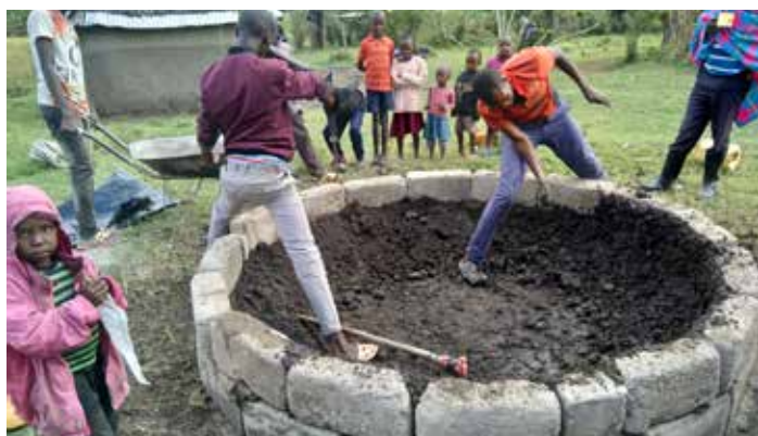
Olekoros, cisterne in aanbouw , sept 2021
