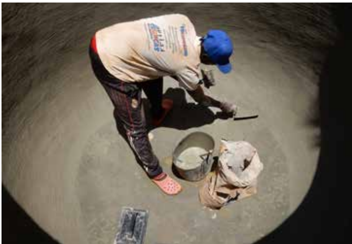
afwerking van de binnenkant van de Calabash Cisterne
