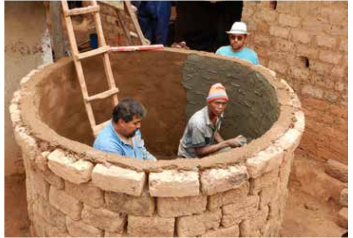
de 1e cement laag aan de binnenzijde van de mal
